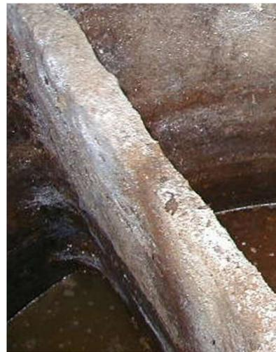
Eine ausreichende Be- und Entlüftung sorgt dafür, dass die in der Kleinkläranlage entstehenden Gase aus der Kleinkläranlage abgeführt werden, ohne Schäden an der Kleinkläranlage oder den Komponenten zu verursachen. Stellt der Servicetechniker bei der Wartung Korrosionsschäden fest, vermerkt er diese im Wartungsprotokoll. Liegt eine Betonkorrosion vor, ist dies in den meisten Fällen auf eine fehlende oder unzureichende Be- und Entlüftung zurückzuführen.
